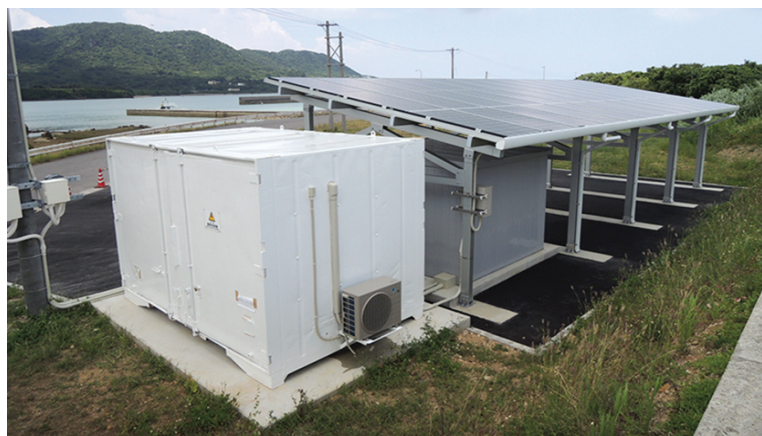
石垣島の自家消費システムー電池容量45kWh
